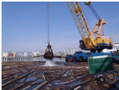
図 18 石巻港における浮遊物揚収状況
