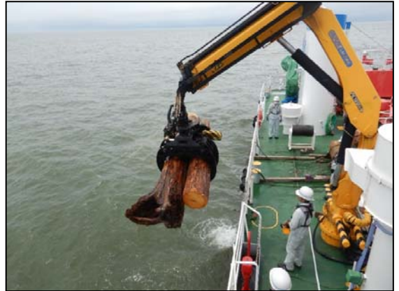
「白龍」のクレーンによる流木の回収作業 (7月10日)
