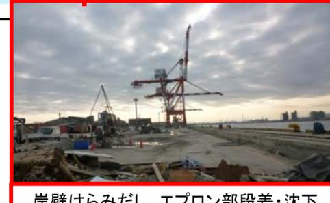
岸壁はらみだし、エプロン部段差・沈下
