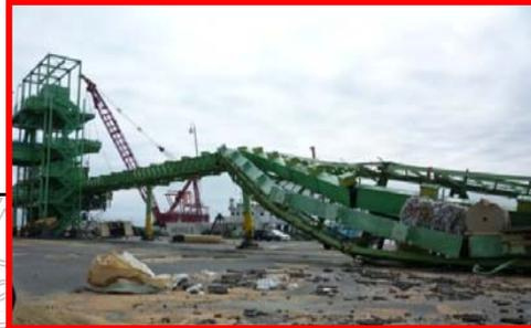
中野1号岸壁ベルトコンベアの倒壊
