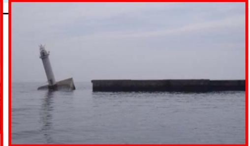
C防波堤 地盤沈下、堤頭陥倒壊
