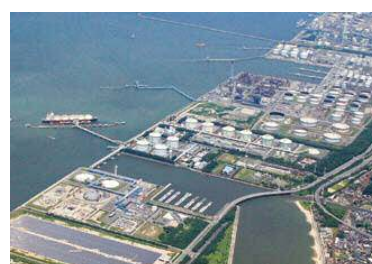
知多 LNG 共同基地と知多緑浜工場 年平均 1 週間に 1 隻の頻度で LNG 輸送船が入港 出典：東邦ガス株式会社資料
