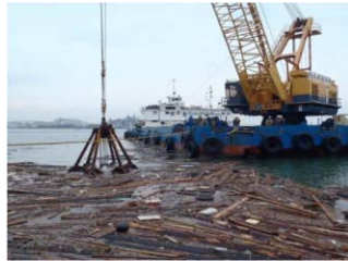
浮遊物・障害物除去作業
