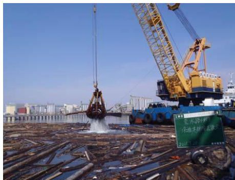
図 18 石巻港における浮遊物揚収状況
