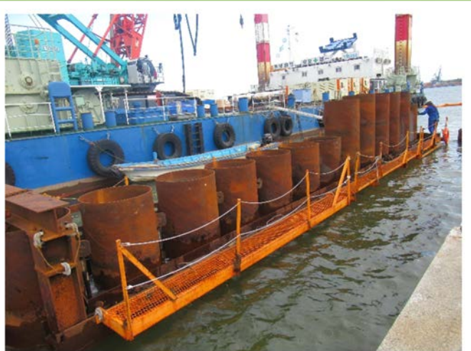
鋼管矢板の打ち込み状況
