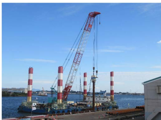
鋼管矢板の打ち込み状況
