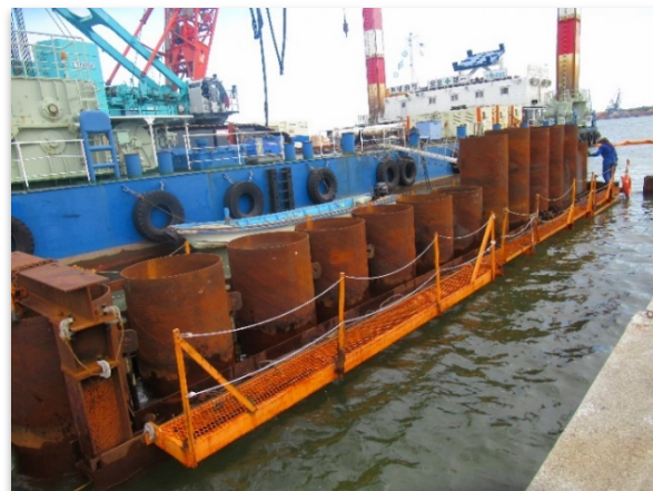
長さ25mの鋼管を打ち込む作業を見学できます！
