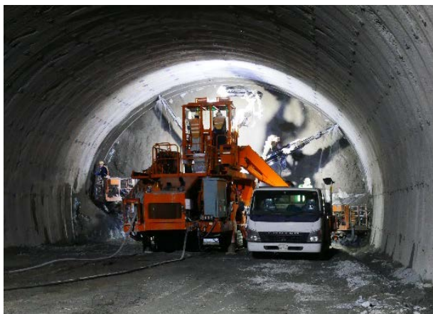
トンネル工事を見学できます！
