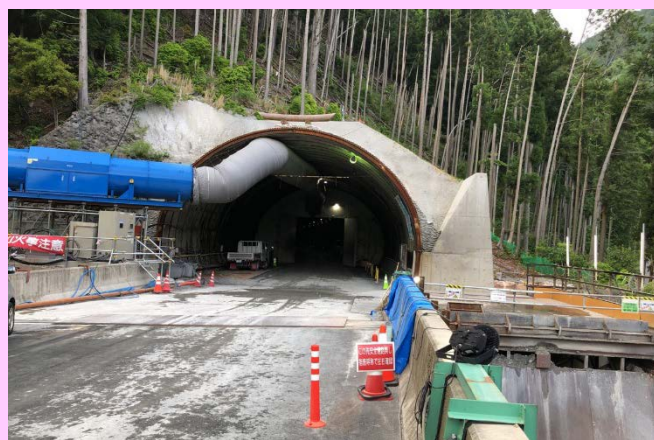
②トンネル本坑の坑口付近(R2.5撮影)
