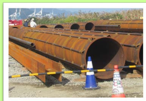
打設する鋼管矢板
