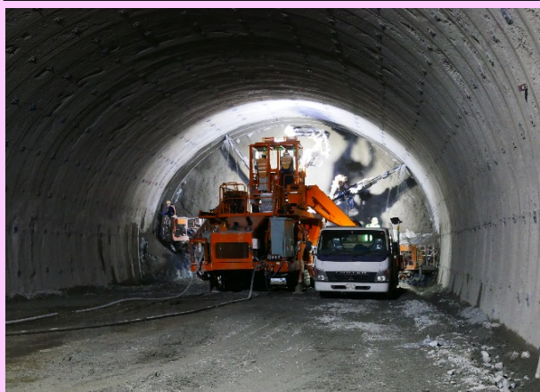
①トンネル本坑の施工状況(R2.1撮影)
