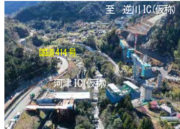
国道 414 号河津下田道路(Ⅱ期) 河津 IC 付近
