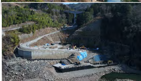
転流工吐口部施工状況
