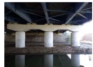
【対策事例】橋梁の耐震補強
