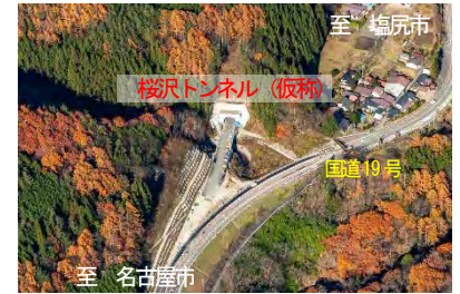
国道 19 号桜沢改良 R3 年秋頃開通に向け工事推進
