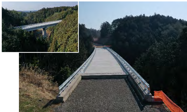
付替道路418号(潮見地区)6号橋
