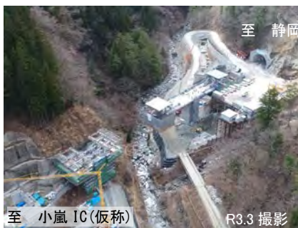
トンネル坑口付近の工事状況 青崩峠道路（長野側）
