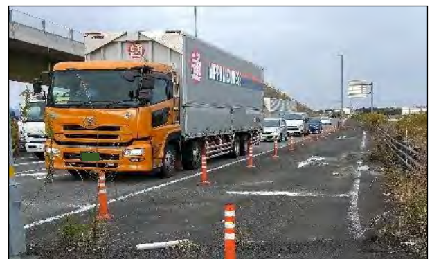
＜＜ 左折車線の延伸を予定 ＞＞
