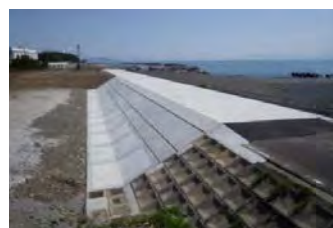
駿河海岸 直轄海岸保全施設整備事業
