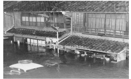
写真1:軒下まで浸水した家屋
