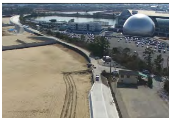
整備前の堤防(阿漕浦・御殿場工区)
