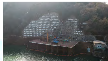
転流工呑口部施工状況
