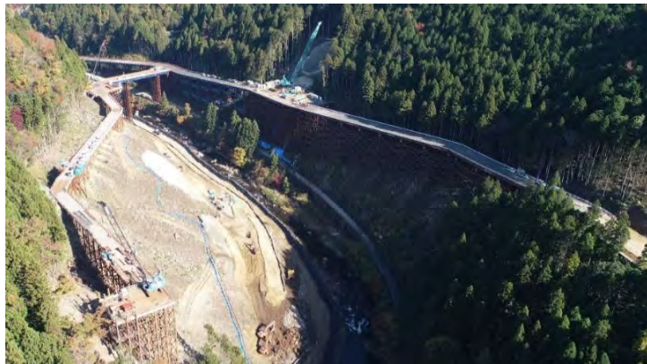
工事用道路(廃棄岩骨材運搬路等)
