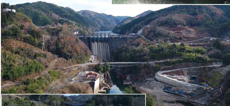
新丸山ダム本体付近施工状況
