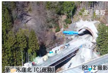
トンネル工事状況（静岡側） 青崩峠道路
