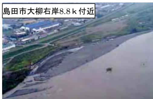
平成12年9月 秋雨前線による河岸侵食状況
