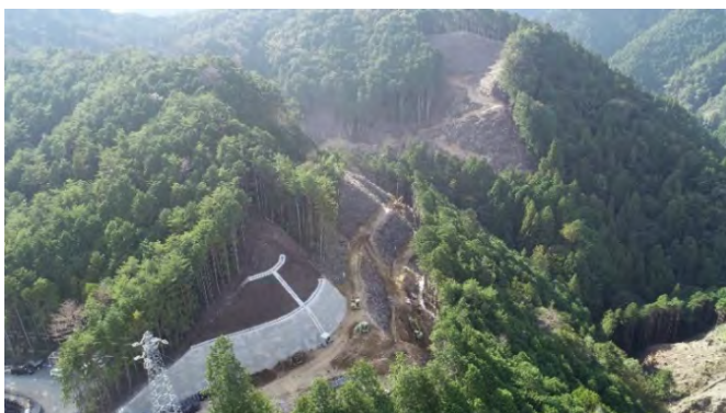
本体工事(基礎掘削)
