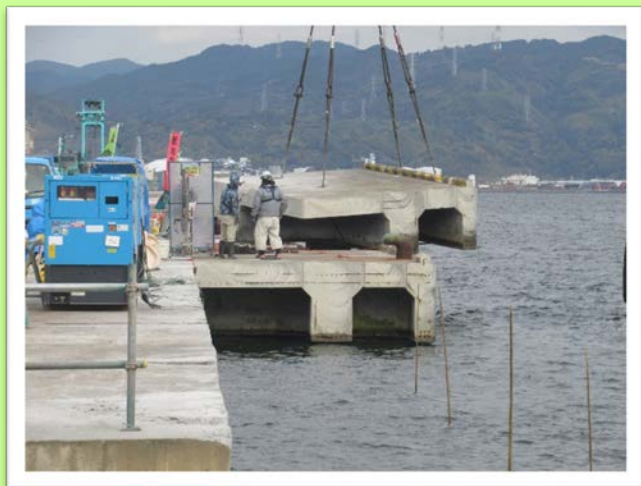
既設岸壁の撤去状況
