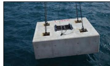
越流による洗掘防止対策
