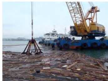
浮遊物・障害物除去作業
