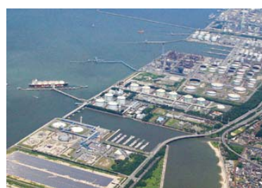
知多 LNG 共同基地と知多緑浜工場 年平均 1 週間に 1 隻の頻度で LNG 輸送船が入港 出典：東邦ガス株式会社資料
