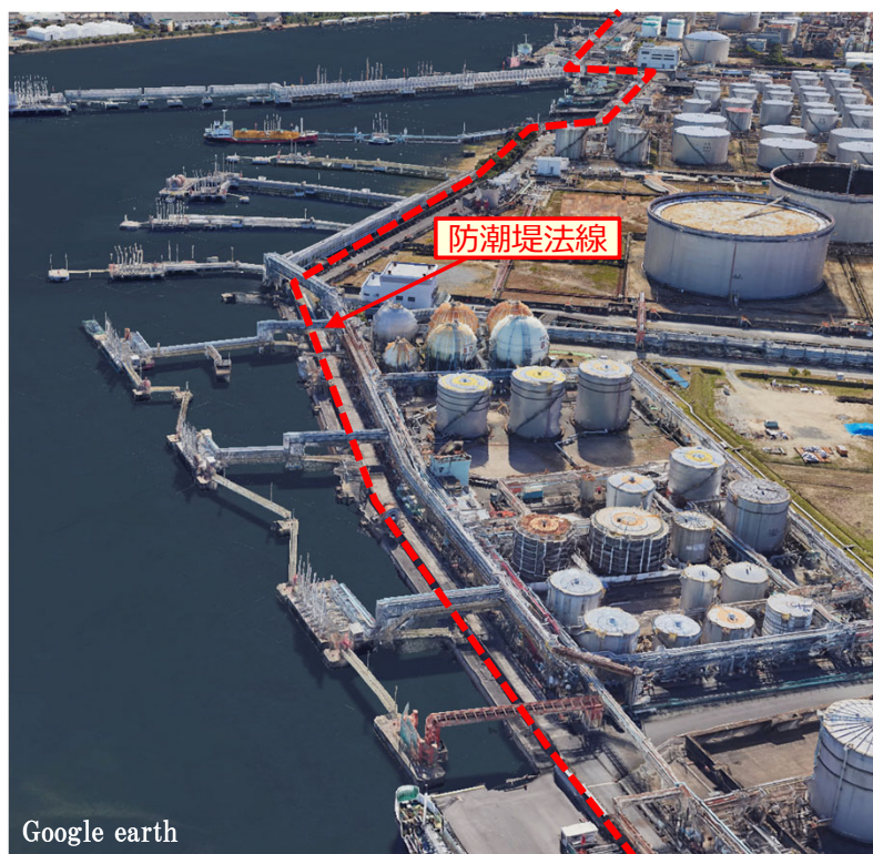
前面水域の企業棧橋と背後の危険物貯蔵タンク等
