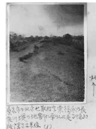
(a)地盤沈下の状況
