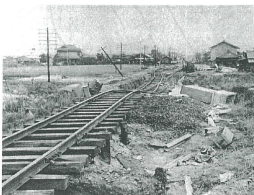
写2-7 濁流で線路敷が流失し、へし曲ったレール (関西線・富田浜駅南)
