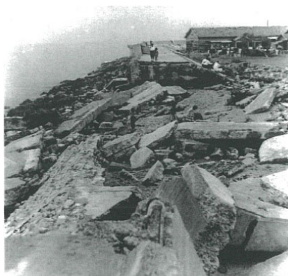
高潮被害で決壊した石原町の堤防
