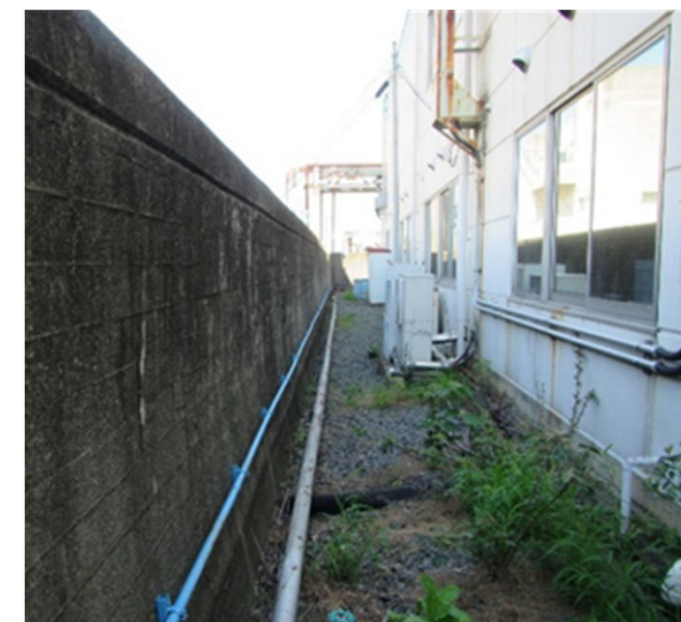
既設防潮堤に近接する建物
