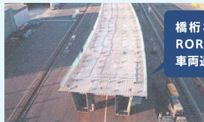
鋼床版箱桁橋施工の様子
