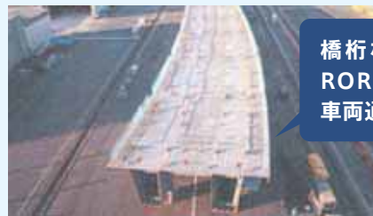
鋼床版箱桁橋施工の様子
