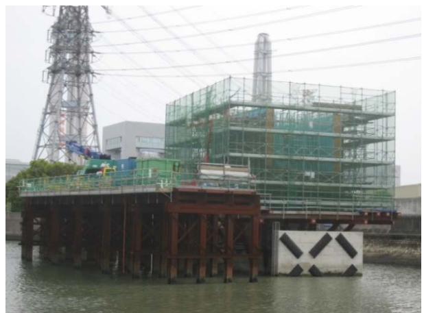
工事現場状況(6工区)・・・橋梁(コンクリート橋)
