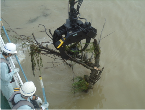
流木の回収状況（1）
