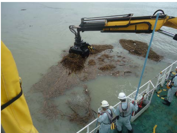
草木の回収状況（1）
