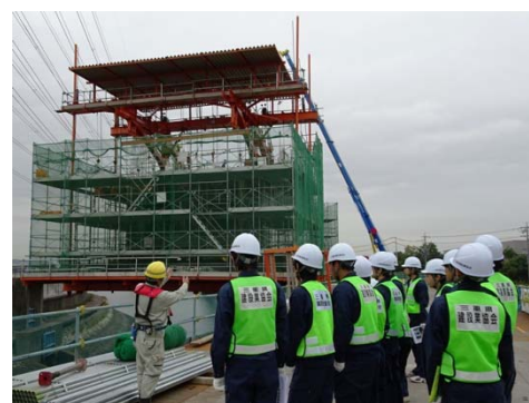
【現場の状況(H28.10時点)】
