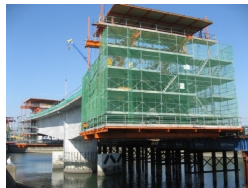
【現場の状況(H28.10 時点)】
