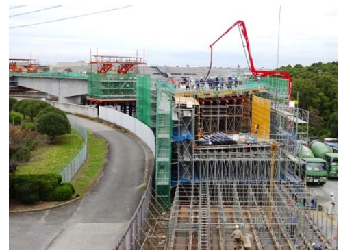
【現場の状況(H28.11 時点)】
