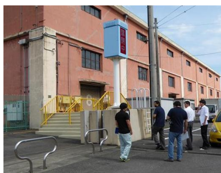
【清水港 防潮堤と津波避難施設を視察】
