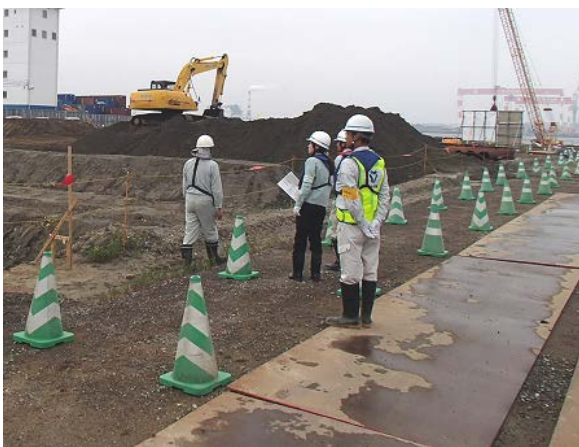
【優れた工夫:コーン色分けによるエリアの危険度の視認化】 (左:安全通路 緑コーン , 右:立入禁止区域 赤コーン)
