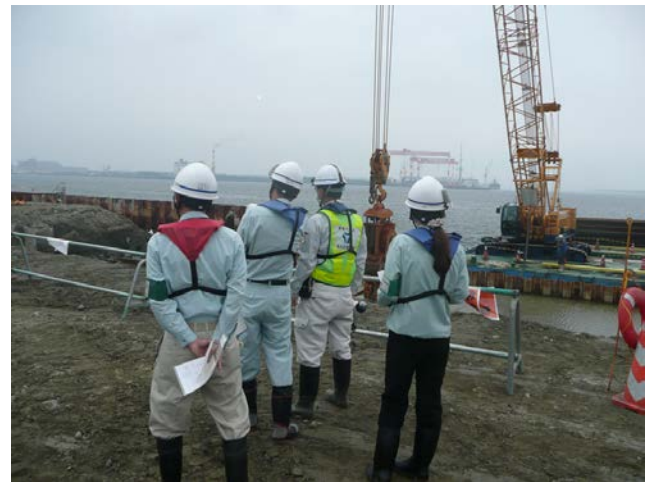
【現場パトロールの様子】
