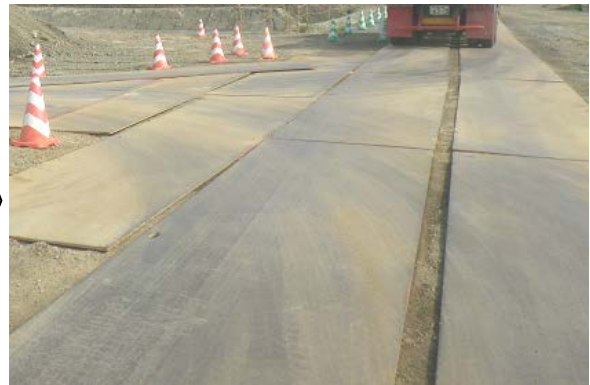
【是正後:敷鉄板の敷き直し】
