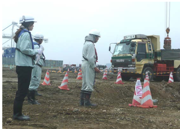
【優れた工夫:コーン色分けによるエリアの危険度の視認化】 (左:安全通路 緑コーン , 右:立入禁止区域 赤コーン)
