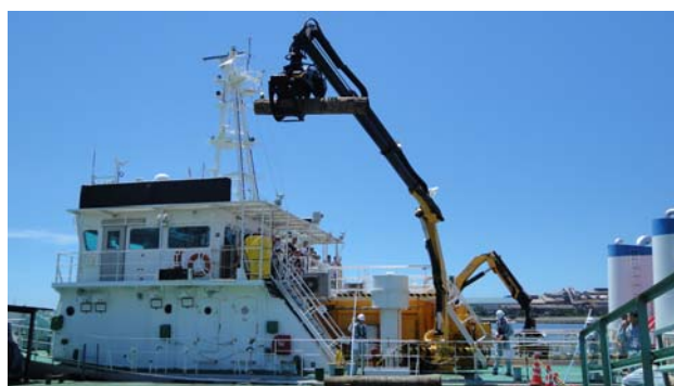
デモンストレーション ～多関節クレーンによる流木回収～
