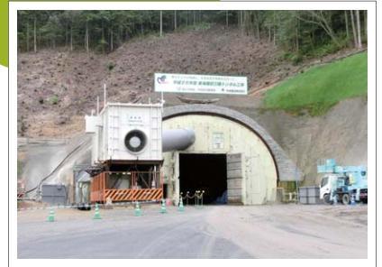
東海環状自動車道トンネル工事現場
