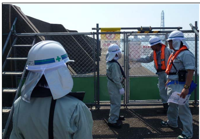
防波堤上の公衆災害防止(侵入対策)状況を点検
