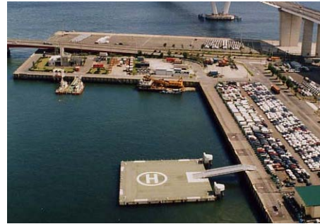
浮体式防災基地(金城ふ頭)
