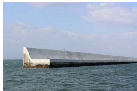
名古屋港高潮防波堤
