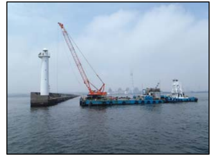
被覆ブロック据付作業の状況
