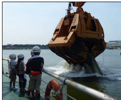
浚渫船のスケールの大きさにビックリ！
