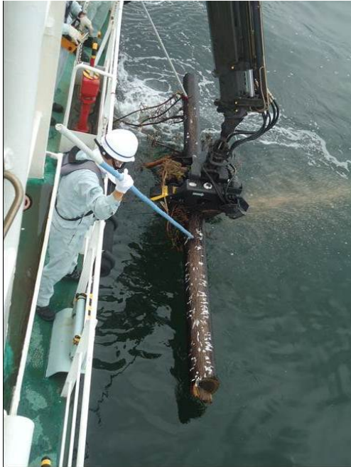
流木の回収状況
