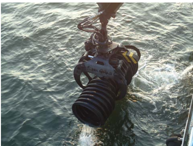
配管回収状況 (径 80cm)
