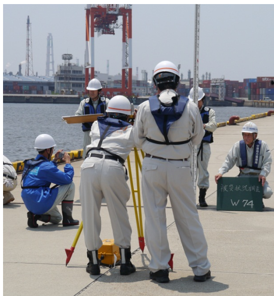
港湾施設の被災状況を調査するエキスパート（イメージ）
