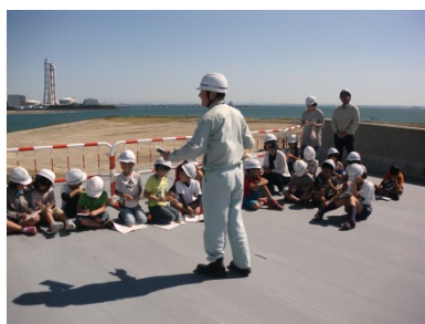
<建設中の臨港道路で>
