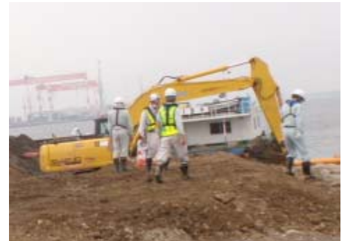
重機の作業状況
