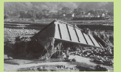
昭和33年(1958)狩野川台風による被害
