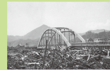
昭和33年(1958)狩野川台風による被害
