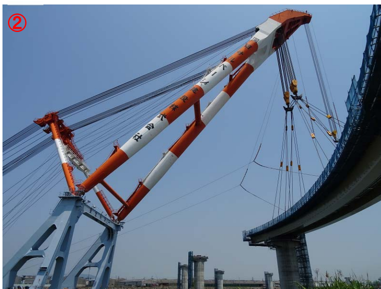
橋桁設置完了(10:30 頃)
