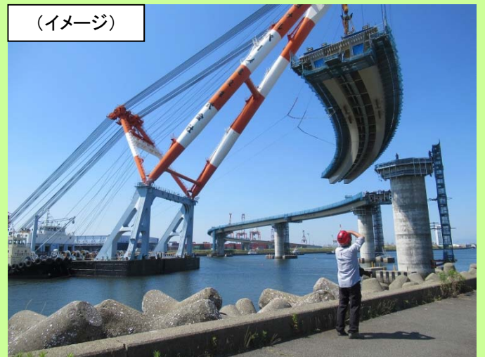
大型クレーンによる海上架設状況
