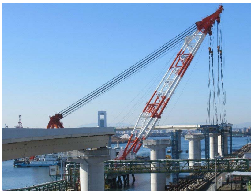
橋桁設置完了(10:00 頃)
