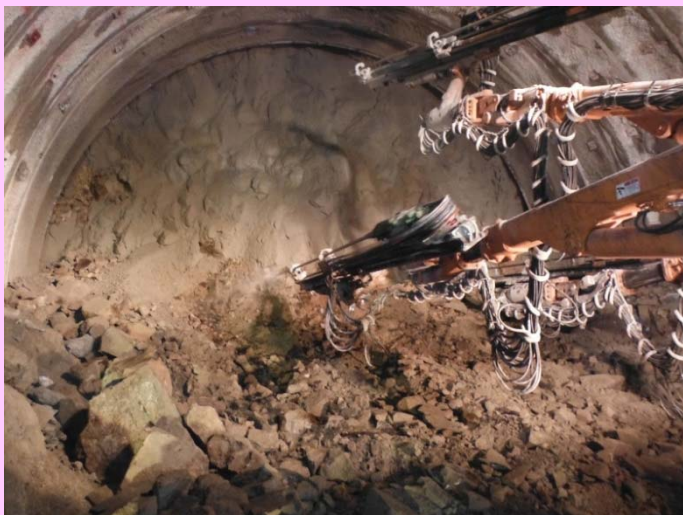
トンネル掘削状況
