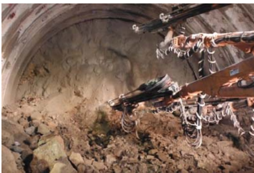
道-2：国道41号 石浦バイパス
