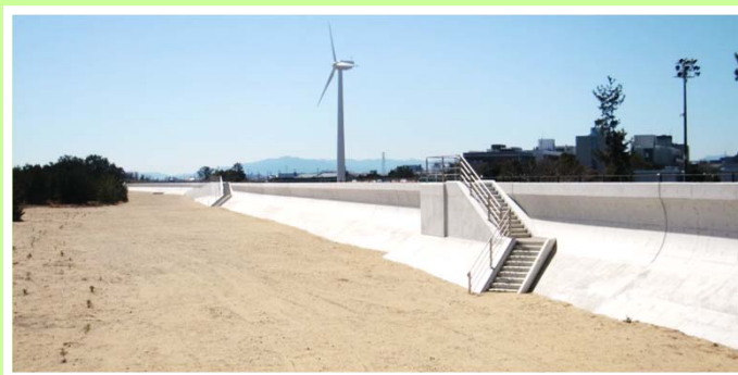
完成した海岸堤防（津地区阿漕浦・御殿場工区）
