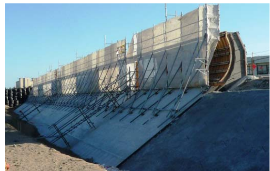
港-7：津松阪港 海岸保全施設の整備
