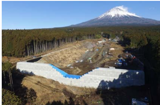
河-2：富士山 鞍骨沢遊砂地工事
