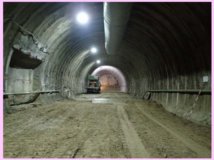
トンネル坑内の様子
