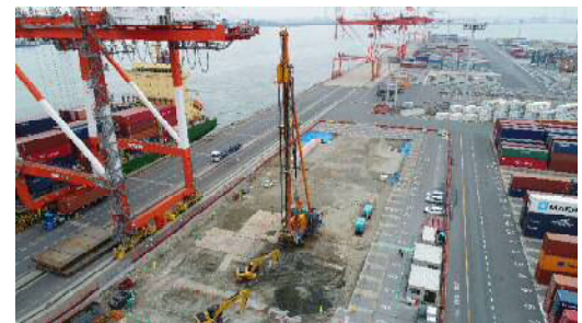
地盤改良工（深層混合処理）の様子
