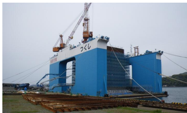
現在製作中のケーソン（4/10撮影）
