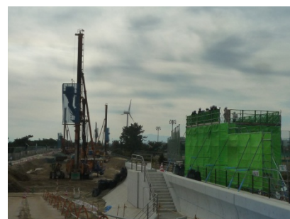
＜ 工事現場全景 ＞
