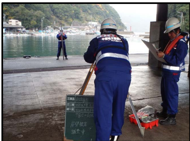
巨大津波襲来、岸壁被害調査 ～TEC-FORCE による被害状況の調査～
