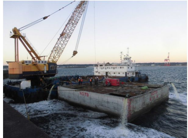
②ケーソン内にある海水を排水
