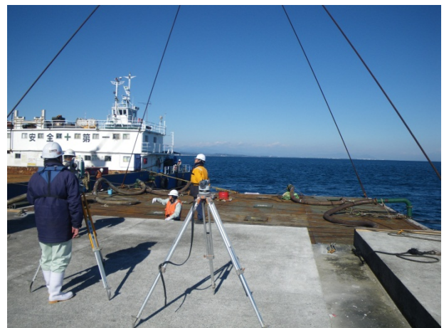
④ケーソンの据付位置を調整
