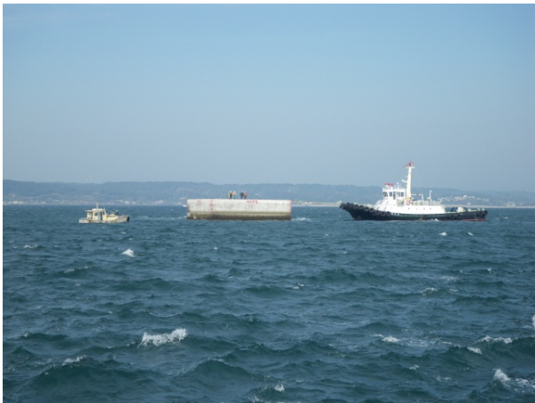
③ケーソンを据付場所まで曳航
