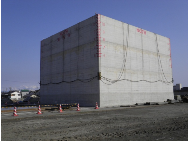
① 据え付けたケーソン
