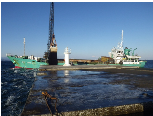
⑤ケーソンに中詰材を投入
