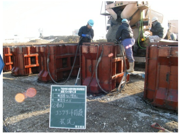
コンクリート打設
