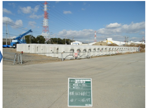
被覆ブロック完成
