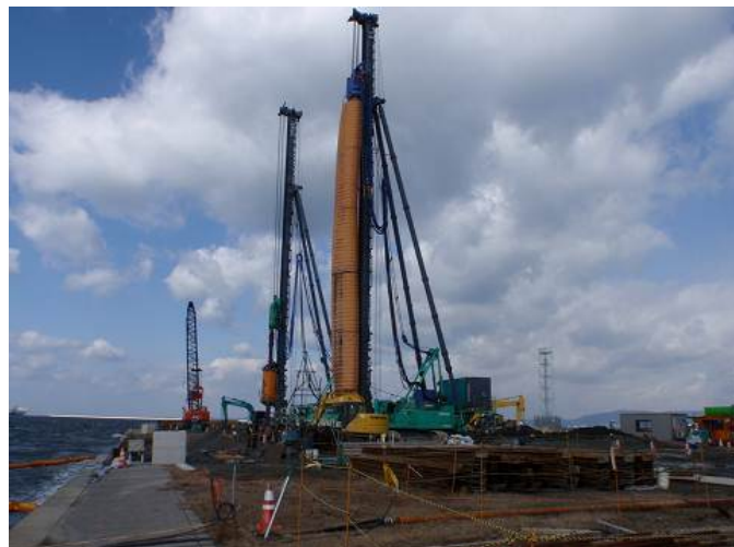
地盤改良状況
