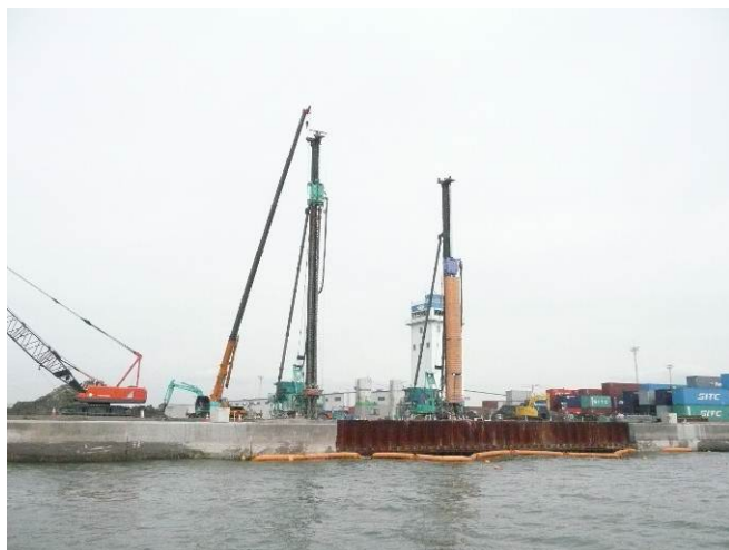
施工状況全景
