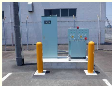
令和4年6月 完成
